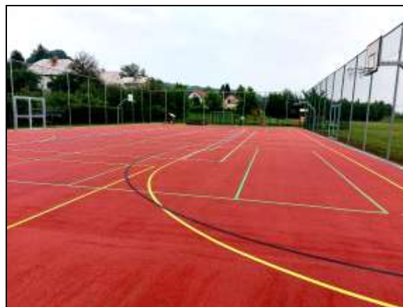
nový stav – po retopingu (transparentní PU nástřik pro bezspádové plochy z EPDM tartanu)
