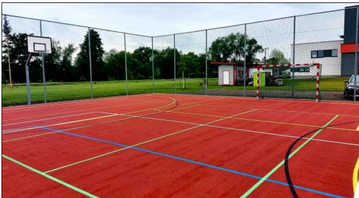
nový stav – po retopingu (transparentní PU nástřik pro bezspádové plochy z EPDM tartanu)
